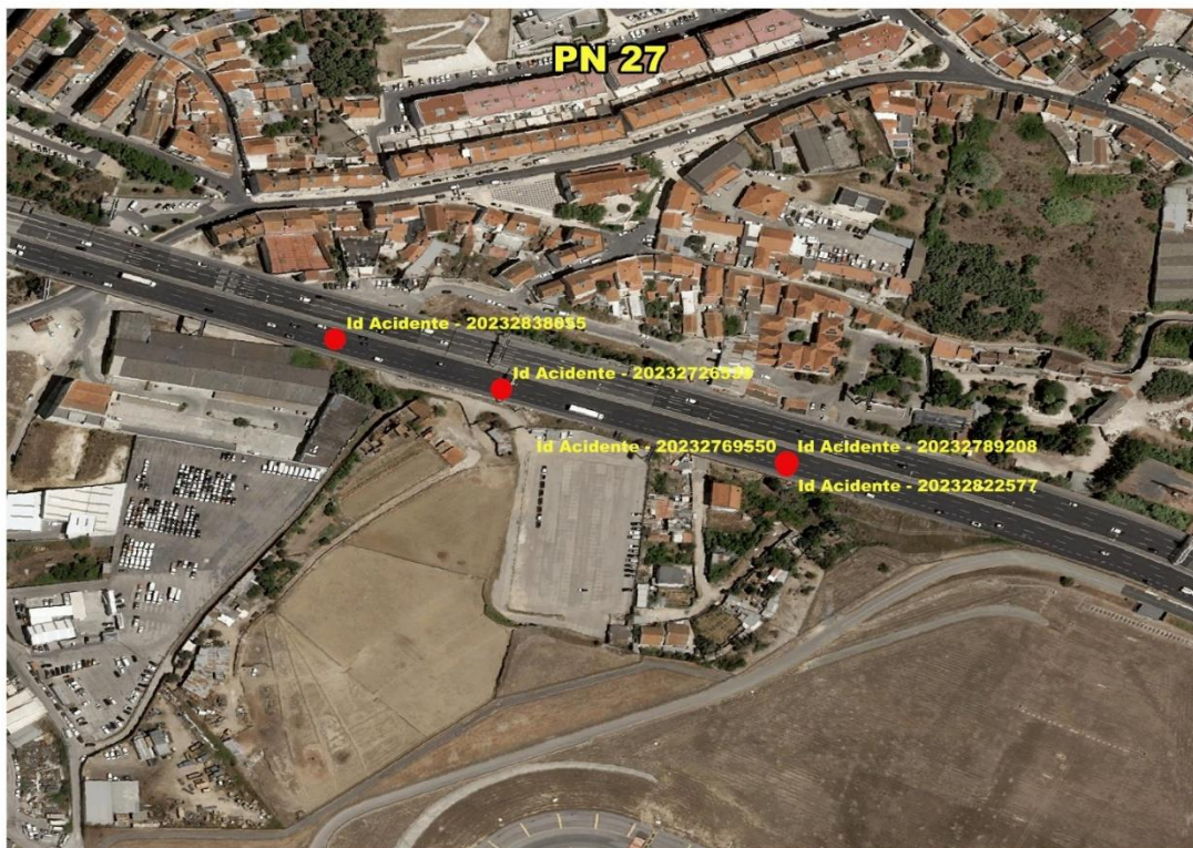
Anexo 27. Ponto Negro 27: Via IC17 _ Km Ponto Negro 17+800 a 18+000 no sentido crescente
